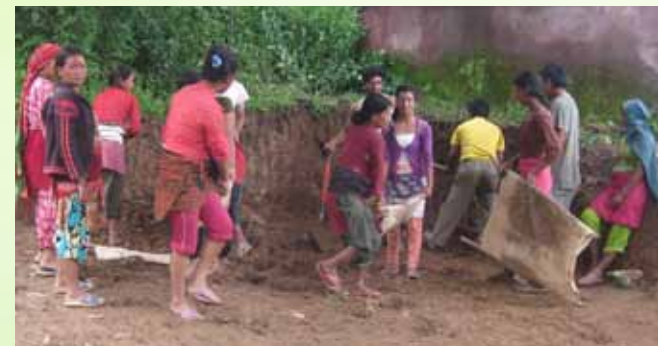
फेरो सिमेन्ट ट्याङ्की निर्माण गर्नका लागि जनश्रमदान गर्दै लेले-७ का स्थानियवासीहरू
